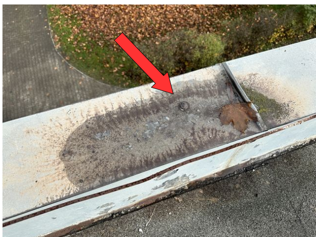
foto /67/ Pohled na lokálně nedostatečně vyspávané místo oplechování atiky
