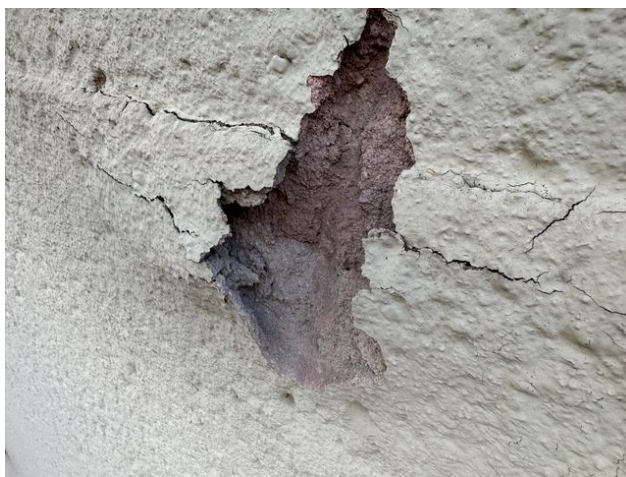
foto /77/ Detail nepřídržné části omítek k podkladu vlivem dlouhodobého zatékání
