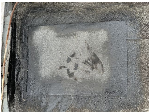
foto /57/ Pohled na zapravení sondy S6 – spodní pás
