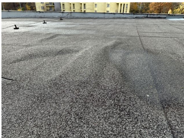
foto /65/ Pohled na tvorbu boulí a zvlnění povlakové hydroizolace střechy C
