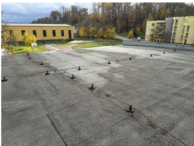
foto /75/ Pohled na bleskosvodnou ochranu střechy C
