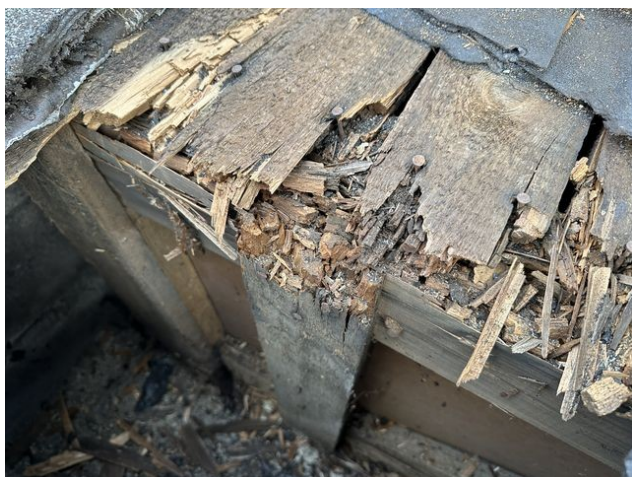
foto /55/ Pohled na porušenou horní část vazníku v místě sondy S7
