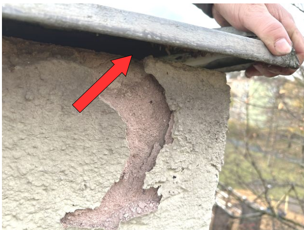
foto /72/ Pohled na vzniklou netěsnost pod oplechováním při nadzvednutí klempířského prvku – nedostatečná stabilizace, absence příponek
