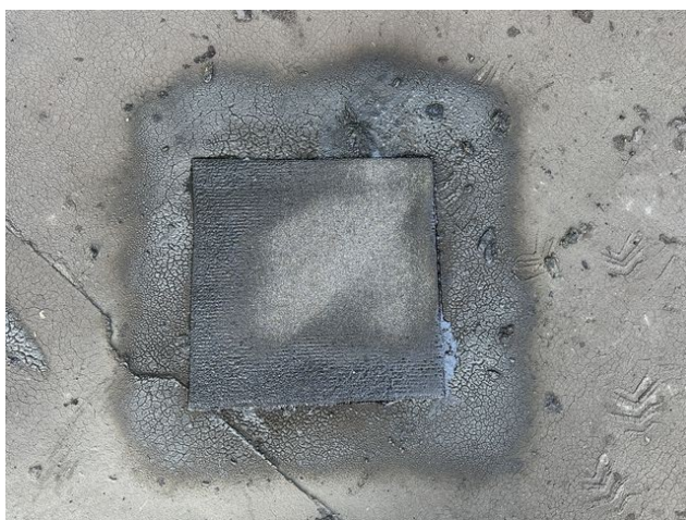
foto /8/ Pohled na zapravené místo sondy S1 – spodní pás
