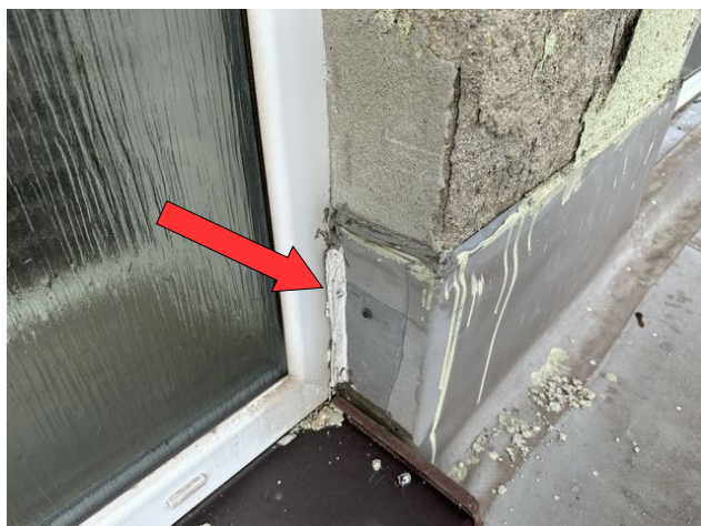
foto /38/ Ostění okna opatřeno pouze poplastovaným plechem pro ukončení hydroizolace, návaznost na okenní rám zatmelena již degradovaným tmelem, netěsná místa vlivem opadání omítky mohou také umožňovat vnikání vlhkosti
