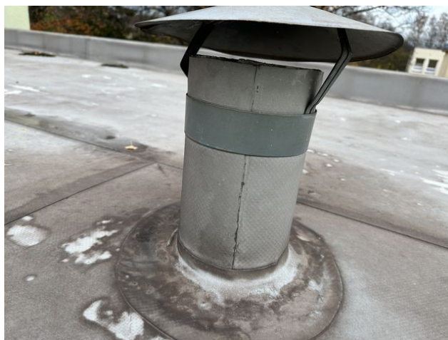
foto /41/ Pohled na opravování kruhových prostupů střechy B povlakovou hydroizolací
