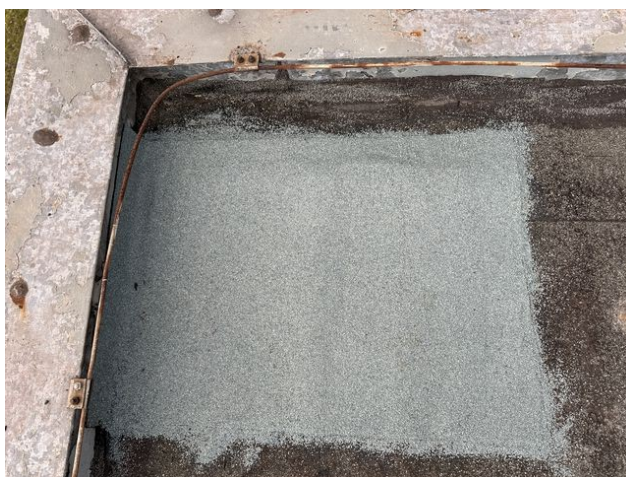
foto /58/ Pohled na zapravení sondy S7 – horní pás
