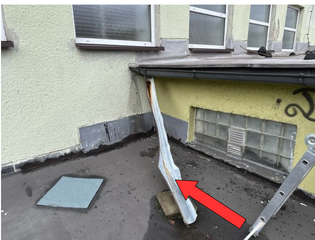
foto /20/ Pohled na provizorní svod střechy B vyvedený na povrch střechy A
