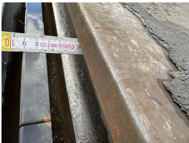
foto /21/ Pohled na detail střešního žlabu - hromadění vody, koroze oplechování
