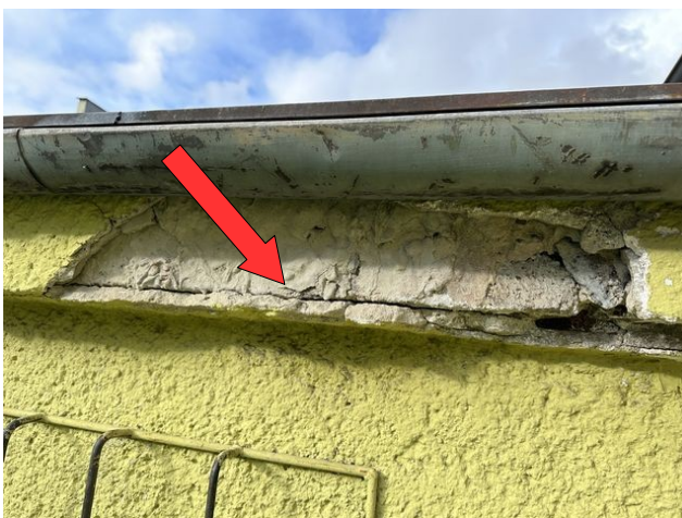
foto /23/ Pohled na opadanou omítku v blízkosti větracího otvoru ve stěně
