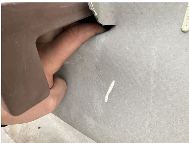
foto /39/ Pohled na netěsné opracování povlakové hydroizolace kolem parapetů okenních výplní
