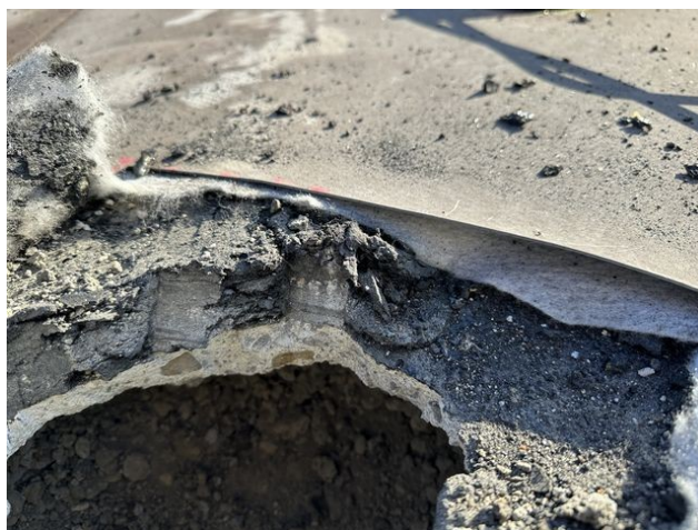
foto /29/ Pohled na odskok vzniklý odstraněním části původní povlakové hydroizolace
