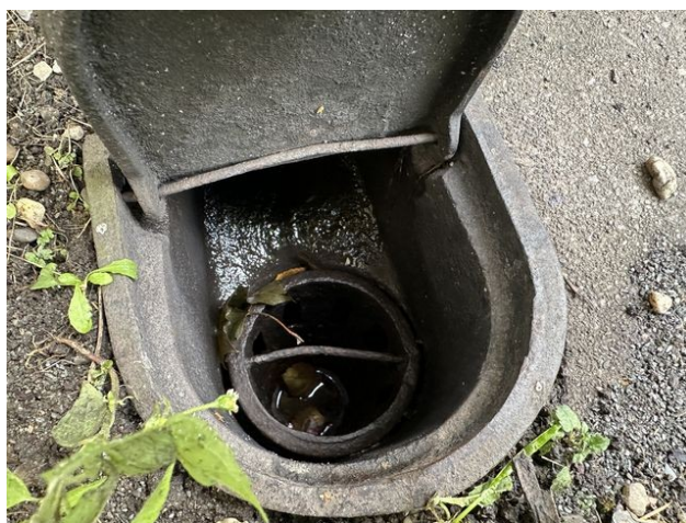
foto /74/ Pohled na vyčištěný lapač střešních splavenin
