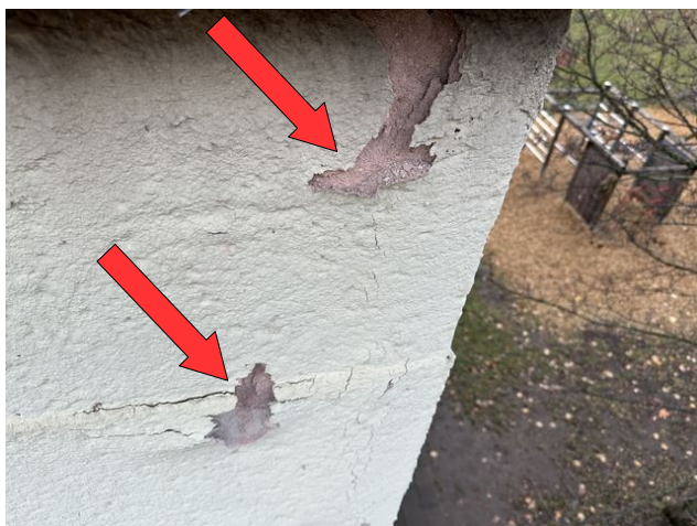
foto /76/ Pohled na opadávání omítek, ve spodní části patrný spoj dílce pro uložení nosníků a konstrukce stěny
