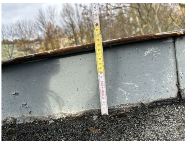
foto /68/ Pohled na ukončení povlakové hydroizolace na oplechování atiky, bez vytažení hydroizolace
