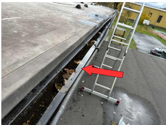
foto /42/ Pohled na hromadění vody v podokapním žlabu
