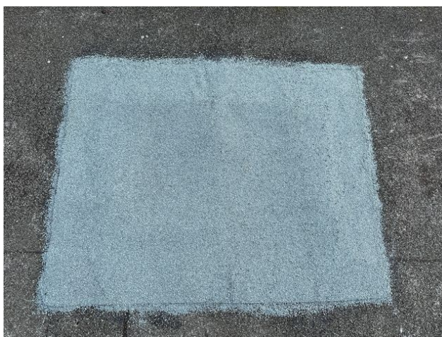
foto /64/ Pohled na zapravení sondy S8 – horní pás
