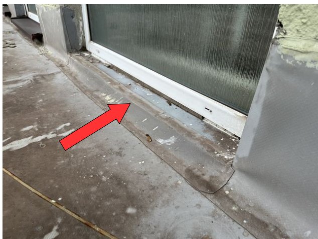
foto /40/ Pohled na nedostatečné vytažení povlakové hydroizolace střešního pláště střechy B
