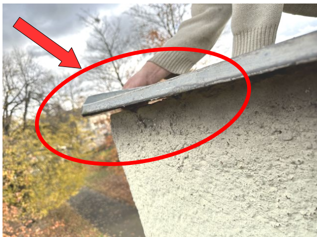
foto /71/ Pohled na vzniklou netěsnost pod oplechováním při nadzvednutí klempířského prvku – nedostatečná stabilizace, absence příponek
