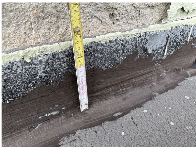
foto /17/ Pohled na způsob ukončení hydroizolace na klempířské prvky u navazující části objektu
