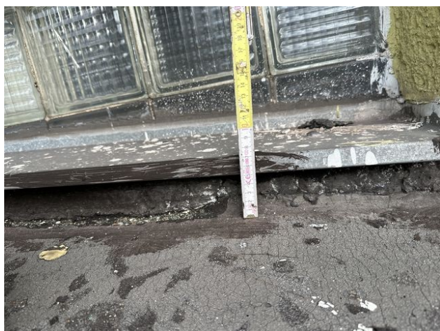
foto /19/ Pohled na nedostatečnou výšku parapetu okna nad střešním pláštěm střechy A
