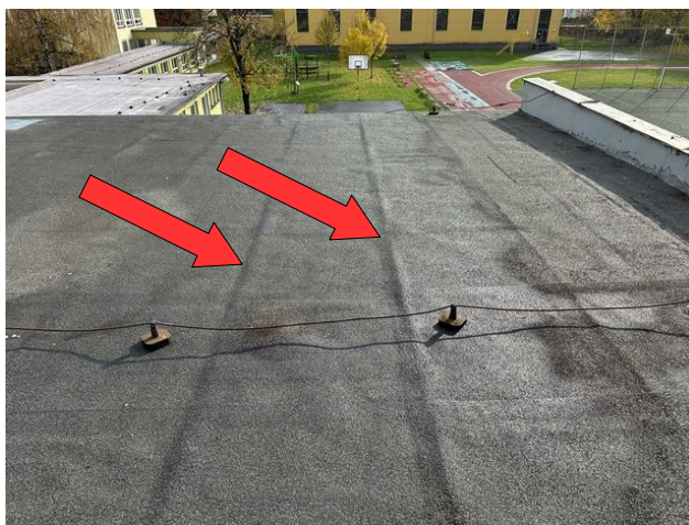
foto /66/ Pohled na viditelná místa stojatých drážek původní falcované krytiny
