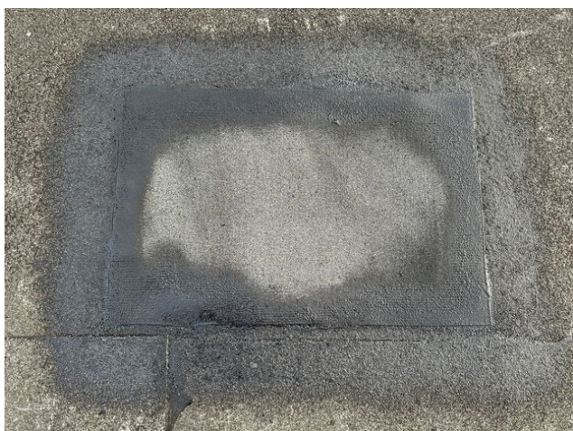
foto /63/ Pohled na zapravení sondy S8 – spodní pás
