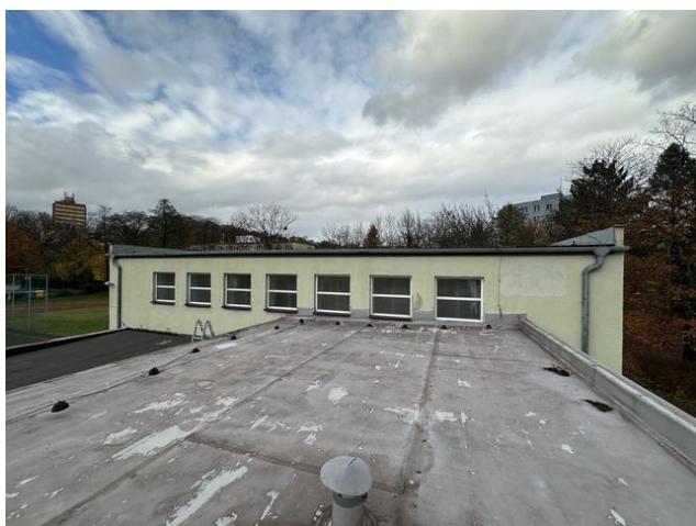
foto /34/ Pohled na střechu B - v ploše střechy jsou viditelné lokální světlejší místa povrchu fólie
