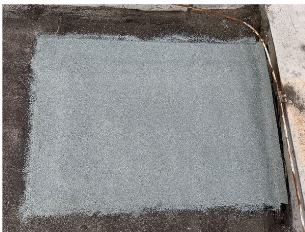
foto /51/ Pohled na zapravení sondy S6 – horní pás
