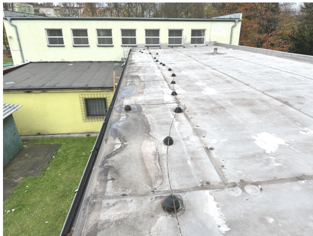
foto /44/ Pohled na část bleskosvodné ochrany střechy B
