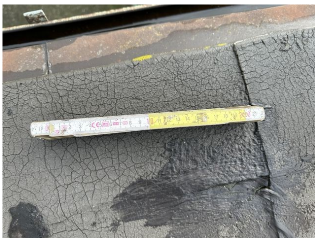
foto /15/ Pohled na tvorbu trhlin ve vrstvě povlakové hydroizolace
