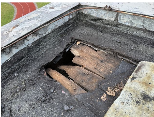
foto /54/ Pohled na provádění sondy S7, viditelná absence části záklopu vlivem degradace dřeva
