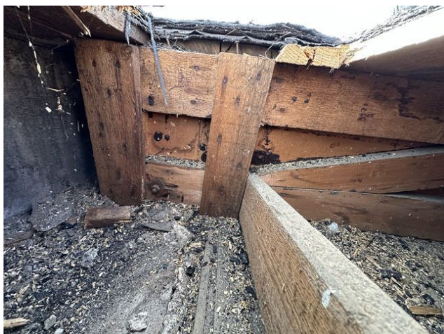
foto /61/ Pohled na místo uložení vazníku v místě sondy S8
