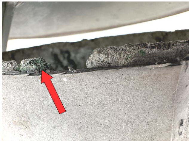
foto /43/ Pohled na viditelnou část materiálu kruhových prostupů – možný výskyt osinkocementu
