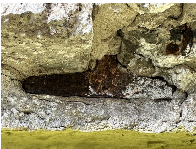
foto /24/ Pohled na viditelnou část nosné konstrukce střechy z ocelového profilu IPN
